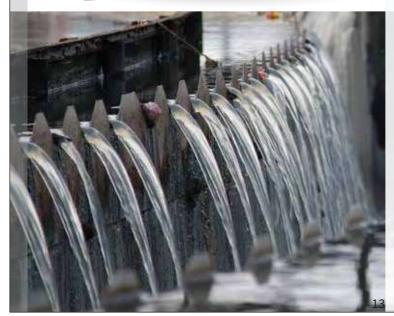
Evsel atık sular, biyolojik olarak arıtılarak deşarj edilir. Sistemdeki aerobik mikroorganizmalar, havalandırma ile sağlanan oksijeni kullanarak organik kirliliği su ve karbondioksite dönüştürür.
